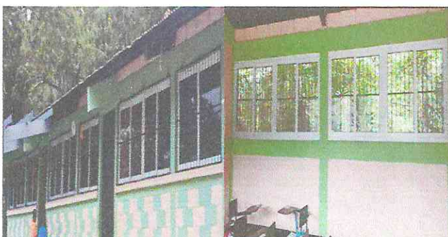
Foto 6: Sustitución de de ventana de pvc y Mantenimiento a Balcones de metal (pintura)
