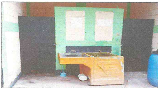
Foto 3: Reparación de puertas de metal (baños)
