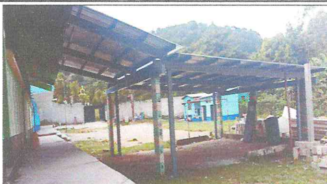
Foto 2: Sustición de Estructura Metalica y Lámina troquelada Aluzinc calibre 26
