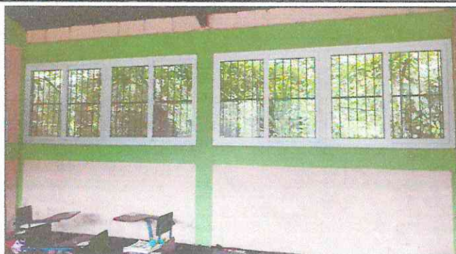
Foto1: Sustitución de de Ventana de PVC y Mantenimiento a Balcones de metal (pintura)
