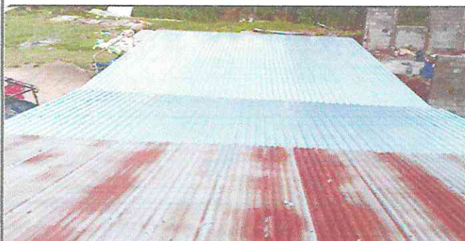
Foto 5: Sustición de Estructura Metalica y Lámina troquelada Aluzinc calibre 26
